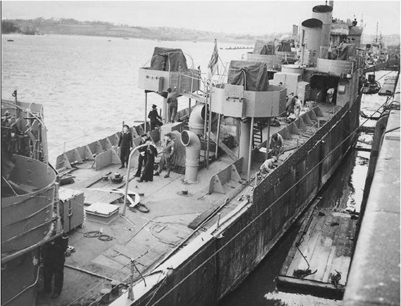
Il cacciatorpediniere britannico Campbeltown convertito, ridotto a due fumaioli, che furono angolati e considerevolmente alleggerito per poter disporre di minore pescaggio e di una maggiore protezione sul ponte dove si dovevano trovare i Commando.
